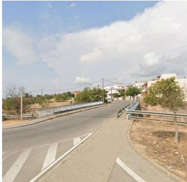
Figura 11. Pas elevat a la C-31 de l'Avinguda de la Torre del Vallès
