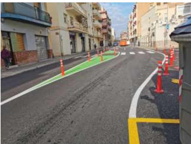
Illeta per a vianants, per facilitar un pas més segur
